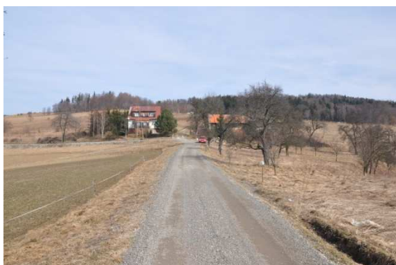
km 0+589 do km 0+642 prawostronny rów melioracyjny (zanikający) w kilometrze początkowym – zrzut wody na pole
