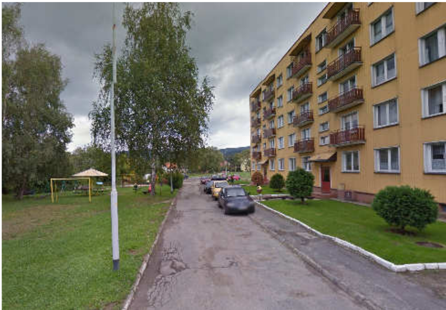
Fot. 6 Odcinek wzdłuż bloku mieszkalnego.
