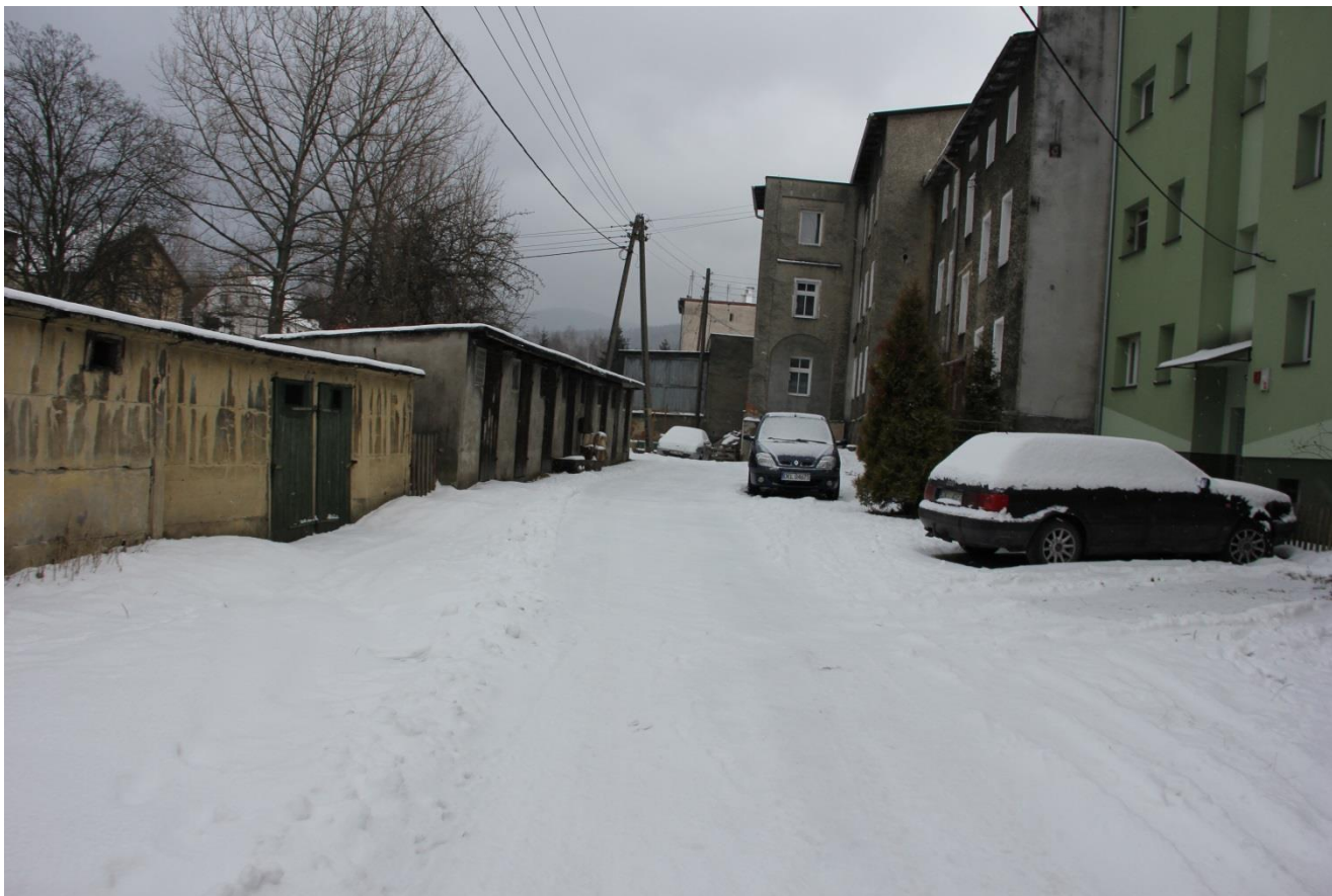
Zdjęcie budynków gospodarczych przeznaczonych do rozbiórki.
