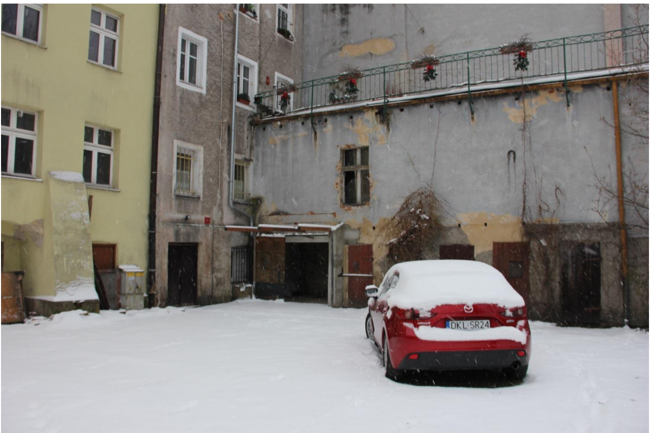
zdjęcie 7 Wejścia do budynków – zachodnia część terenu
