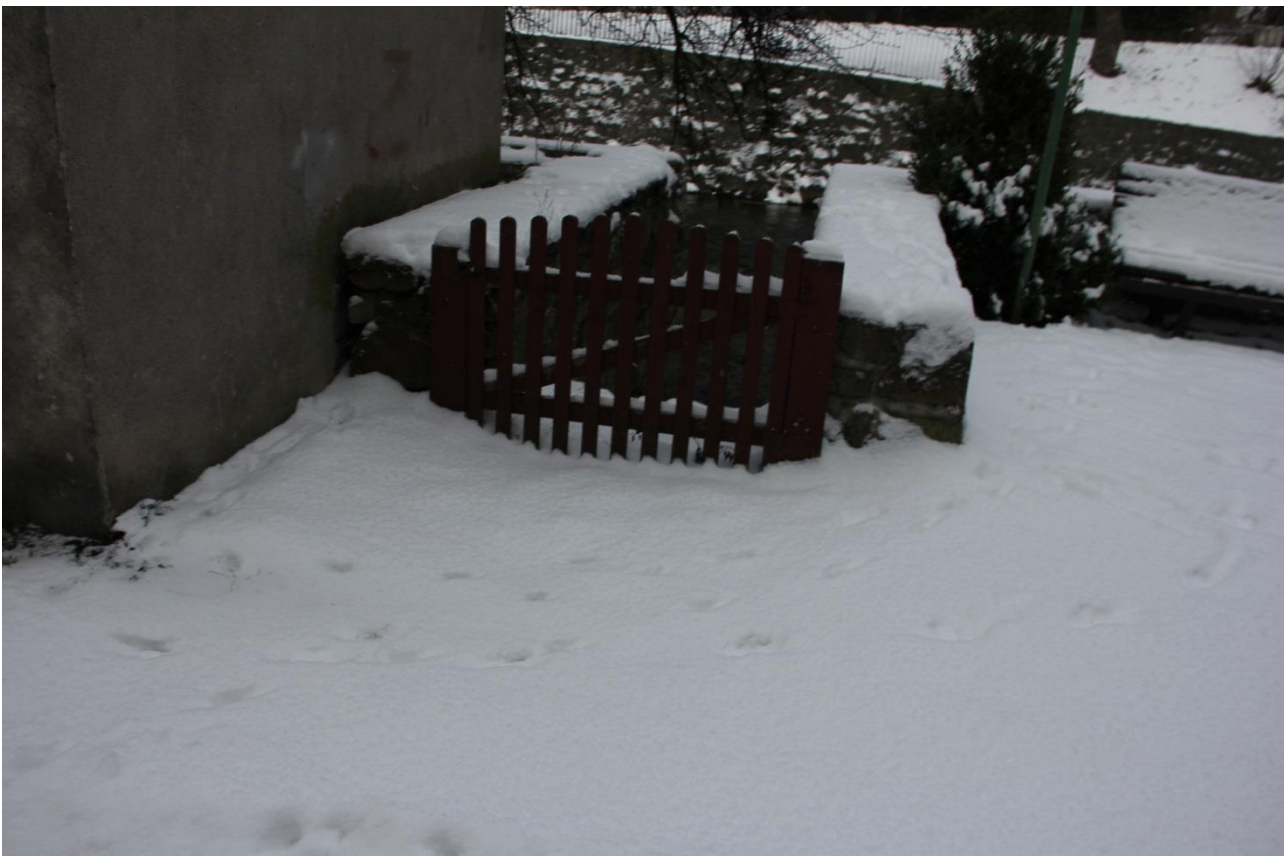
zdjęcie 3 Istniejące zejście i murek przy rzece Biała Łądecka
