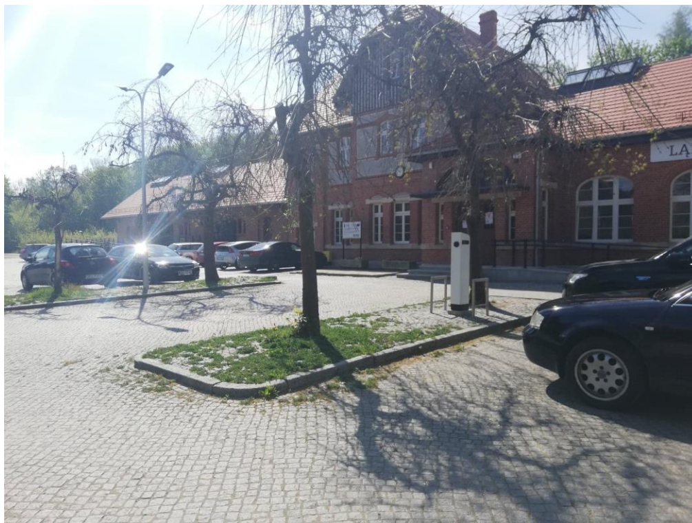
Rysunek 1. Stacja ładowania pojazdów elektrycznych w Łądku-Zdroju
