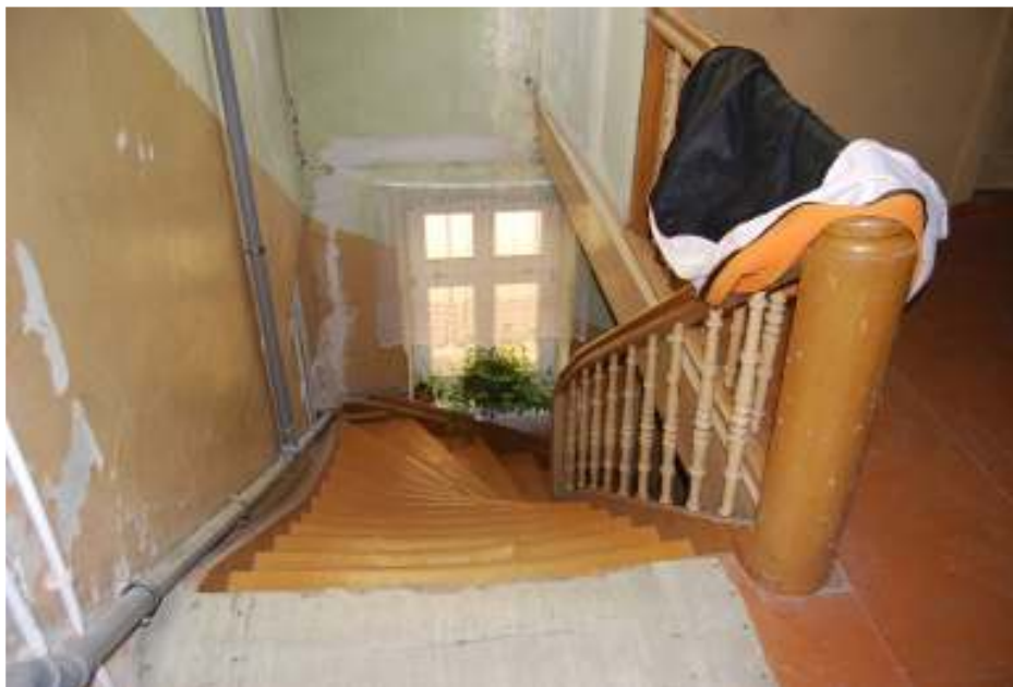
Klatka schodowa w poziomie poddasza – schody, balustrady do remontu, zaprojektowane wydzielenie klatki schodowej nowo projektowanymi ścianami gk.
