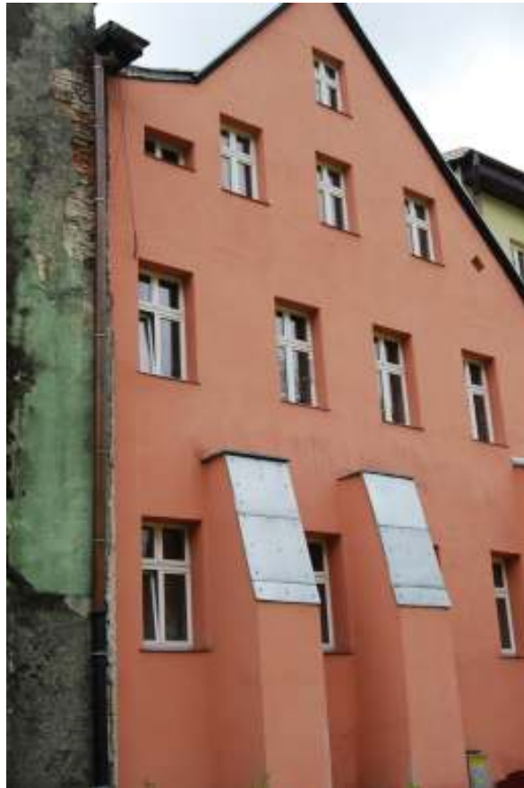
Elewacja tylna- widoczne wymienione rury spustowe, stolarka okienna.
