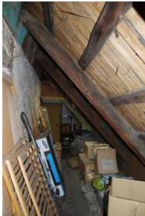
Przestrzeń strychowa w poziomie poddasza – od strony elewacji bocznej.
