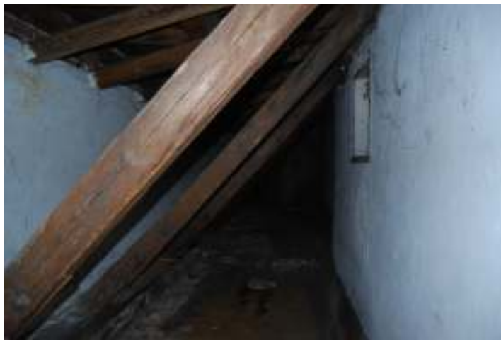
Przestrzeń strychowa w poziomie poddasza – widoczna konstrukcja koryta odwadniającego.
