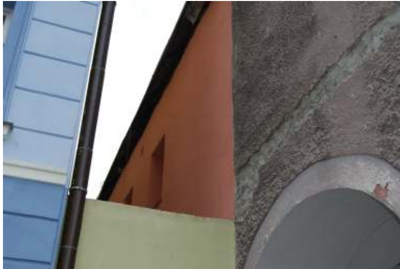
Elewacja boczna – w części wyremontowana.
