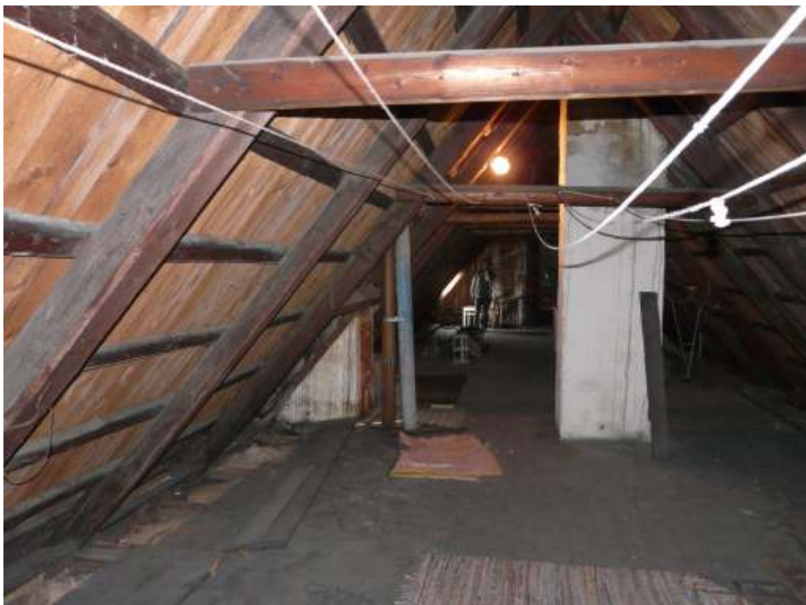
Fot.5 Więźba dachowa , odkrywka belek stropu nad poddaszem
