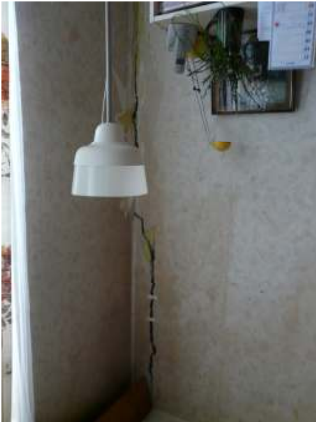
Fot. 3 Jedno z uszkodzonych nadproży w ścianie frontowej.
