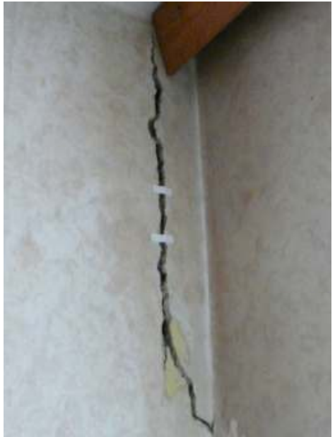
Fot. 3 Jedno z uszkodzonych nadproży w ścianie frontowej.
