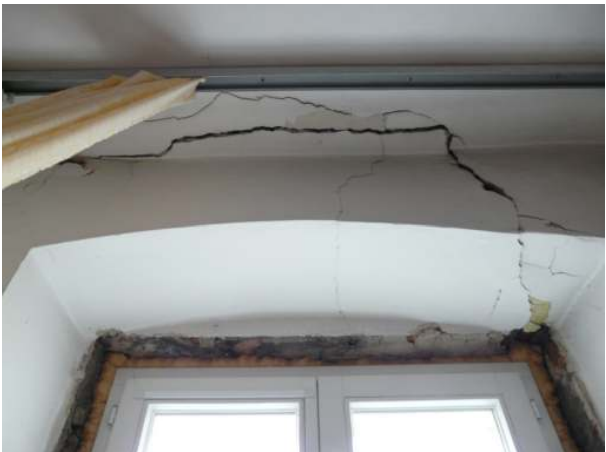
Fot. 3 Jedno z uszkodzonych nadproży w ścianie frontowej.
