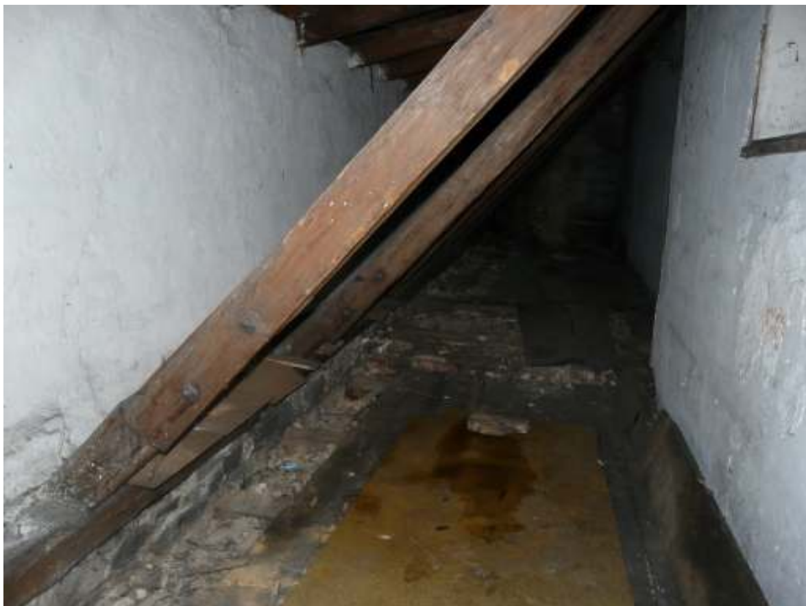
Fot.5 Więźba dachowa , odkrywka belek stropu nad poddaszem
