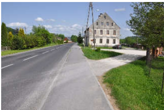
Km 0+000,00 Początek przebudowywanej drogi
