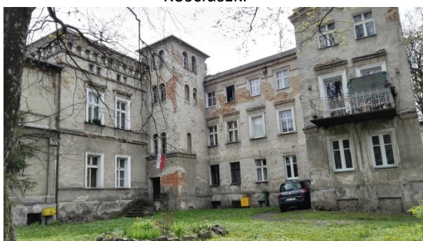
Fotografia: Kamienica mieszkalna przy ul. Przechodniej
