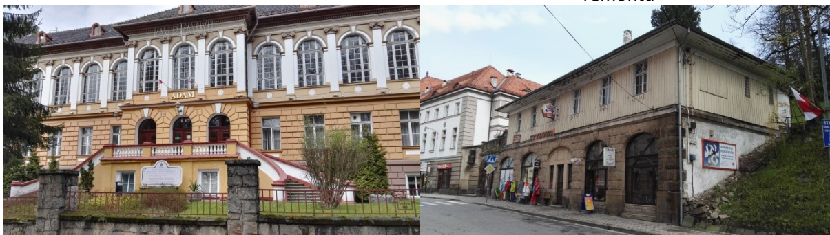
Fotografia: Obiekt ZPL „Adam” przy ul. Wolności, wymaga termomodernizacji
