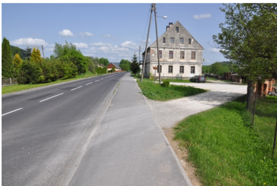
Km 0+000,00 Początek przebudowywanej drogi
