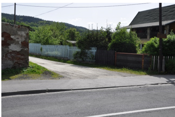
Km 0+813,62 koniec przebudowy odcinka
