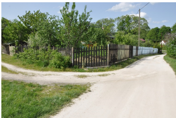
Km 0+760,77 skrzyżowanie dróg 423 i 428
