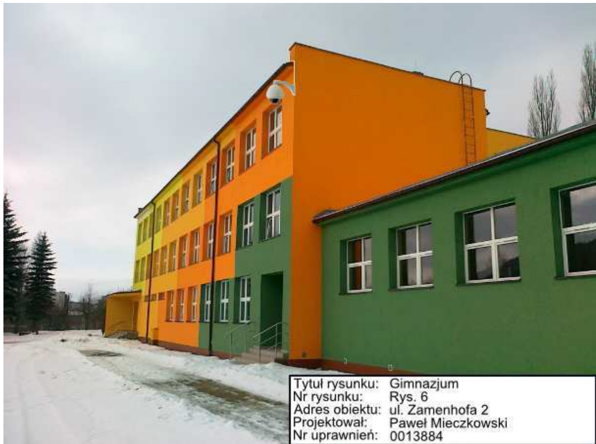
Rys6 Kamera K3 na budynku Gimnazjum przy ul. Zamenhofa 2
