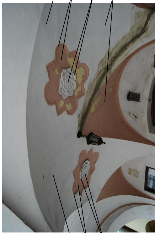
Detail na sklepieniach podcienia.
