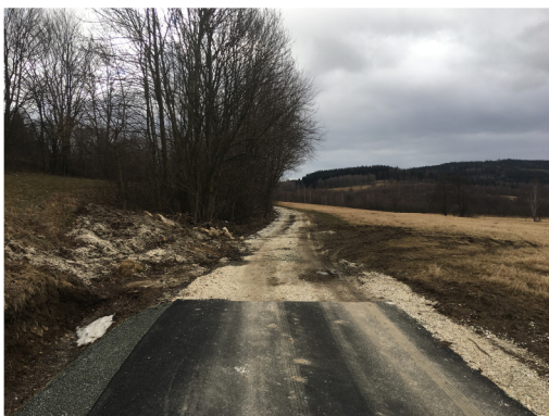
km 0+484,30 Początek przebudowy odcinka
