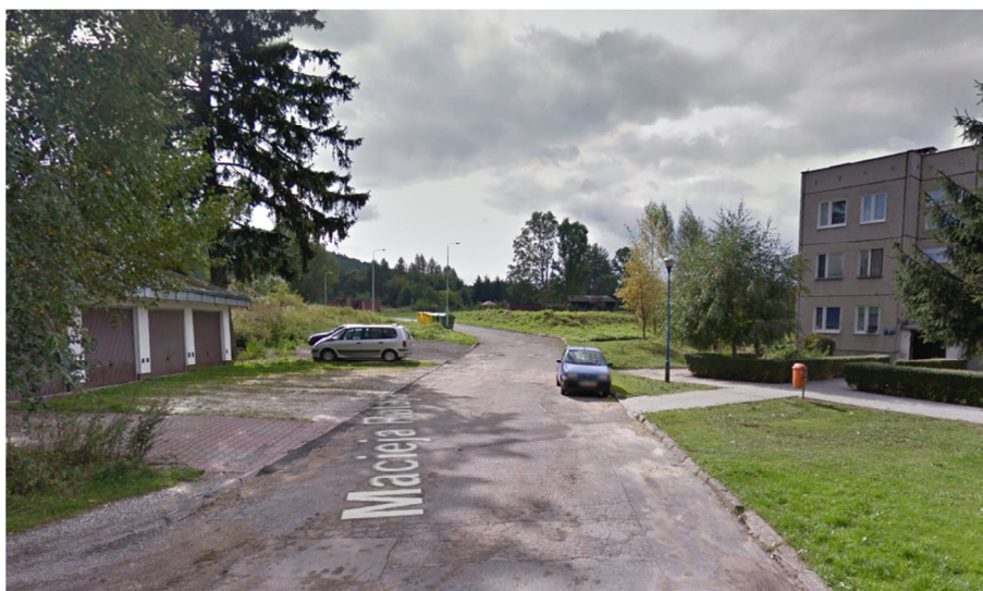
Fot. 3 Odcinek wymagający korekty przebiegu drogi
