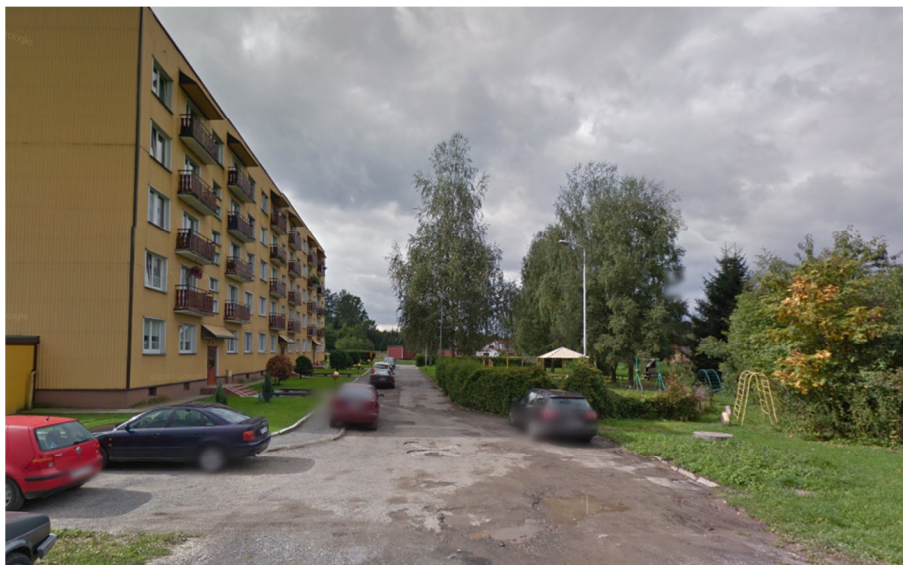
Fot. 7 Koniec przebudowy ul. Rataja
