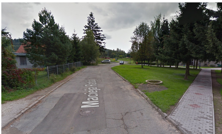
Fot. 2 Początkowy odcinek przebudowy
