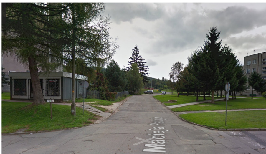
Fot. 1 Początek przebudowywanej drogi skrzyżowanie z ul. Powstańców Wlkp.
