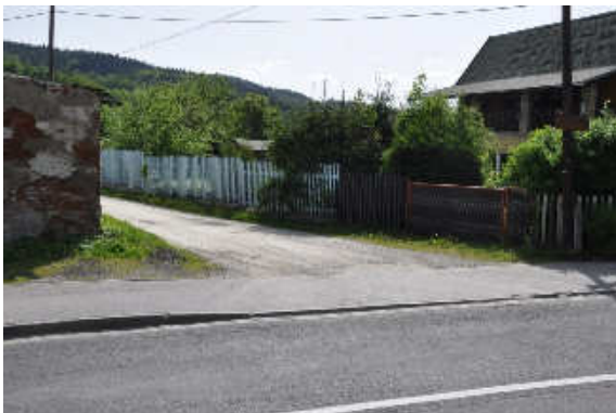
Km 0+813,62 koniec przebudowy odcinka
