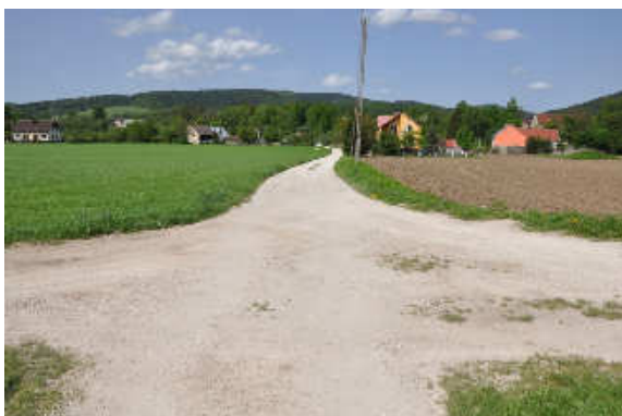
Km 0+595,57 skrzyżowanie dróg nr 407 i 428 oraz z drogą nr 401/2
