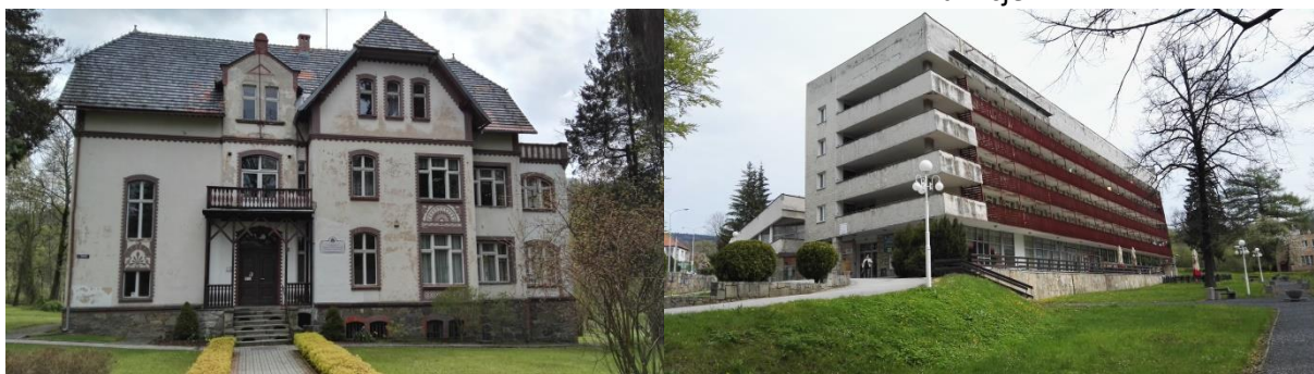
Fotografia: budynek mieszkalno-usługowy przy ul. Kościuszki, zgłoszony do adaptacji pod inne funkcje
