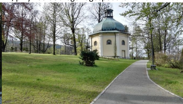
Fotografia: Park przy ul. Leśnej, przykład dobrego zagospodarowania, budynek kaplicy wymagający remontu
