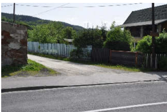
Km 0+813,62 koniec przebudowy odcinka
