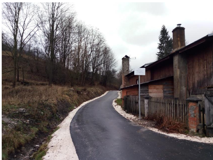
Konradów - przebudowa drogi gminnej wewnętrznej nr 268 – jezdnia 550 m
