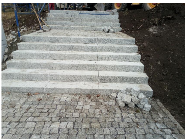
pl. M.C. Skłodowskiej – przebudowa schodów
