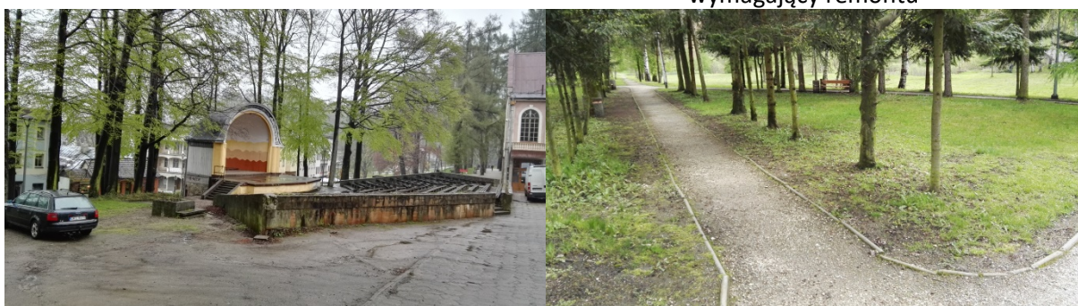
Fotografia: Przestrzeń publiczna i muszla koncertowa przy ul. Orlej i Cienistej, wymaga modernizacji i remontu
