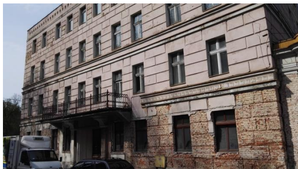
Fotografia: Kamienica mieszkalna przy ul. Kościuszki
