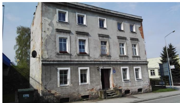
Fotografia: Kamienica mieszkalna przy ul. Kościuszki
