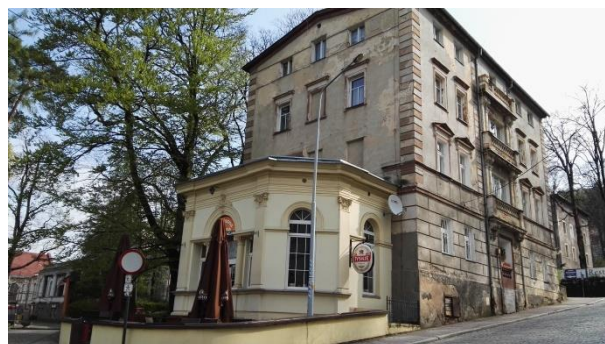
Fotografia: Kamienica mieszkalna przy ul. Ostrowicza
