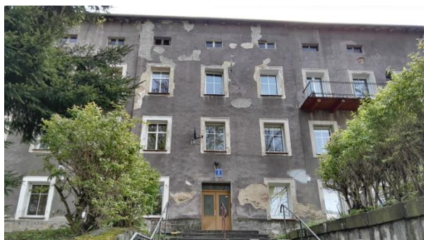
Fotografia: Kamienica mieszkalna przy ul. Orlej
