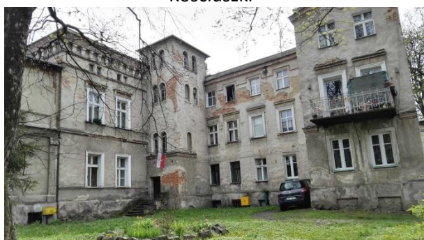
Fotografia: Kamienica mieszkalna przy ul. Przechodniej
