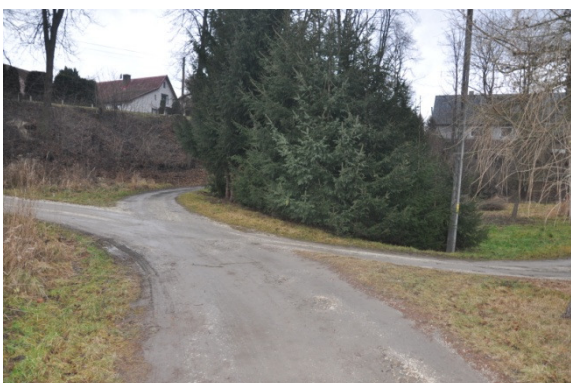
km 0+535,40 skrzyżowanie dróg nr 501, 531, 535 oraz zjazd na teren działki nr 529 (prawy)
