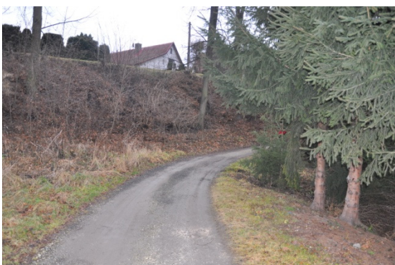
km 0+20,20 koniec przebudowy odcinka III działka nr 531
