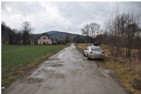
km 0+000 początek odbudowy dróg nr 501, 531 i 535
