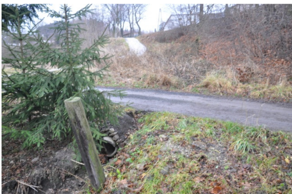
km 0+16,95 przepust do przebudowy (odcinek III)
