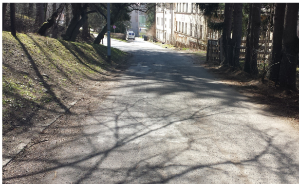
km 0+200 koniec przebudowy odcinka AB początek przebudowy odcinka BC
