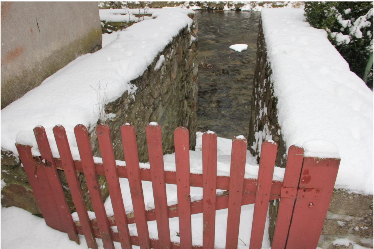
zdjęcie 4 Istniejące zejście i murek przy rzece Biała Łądecka
