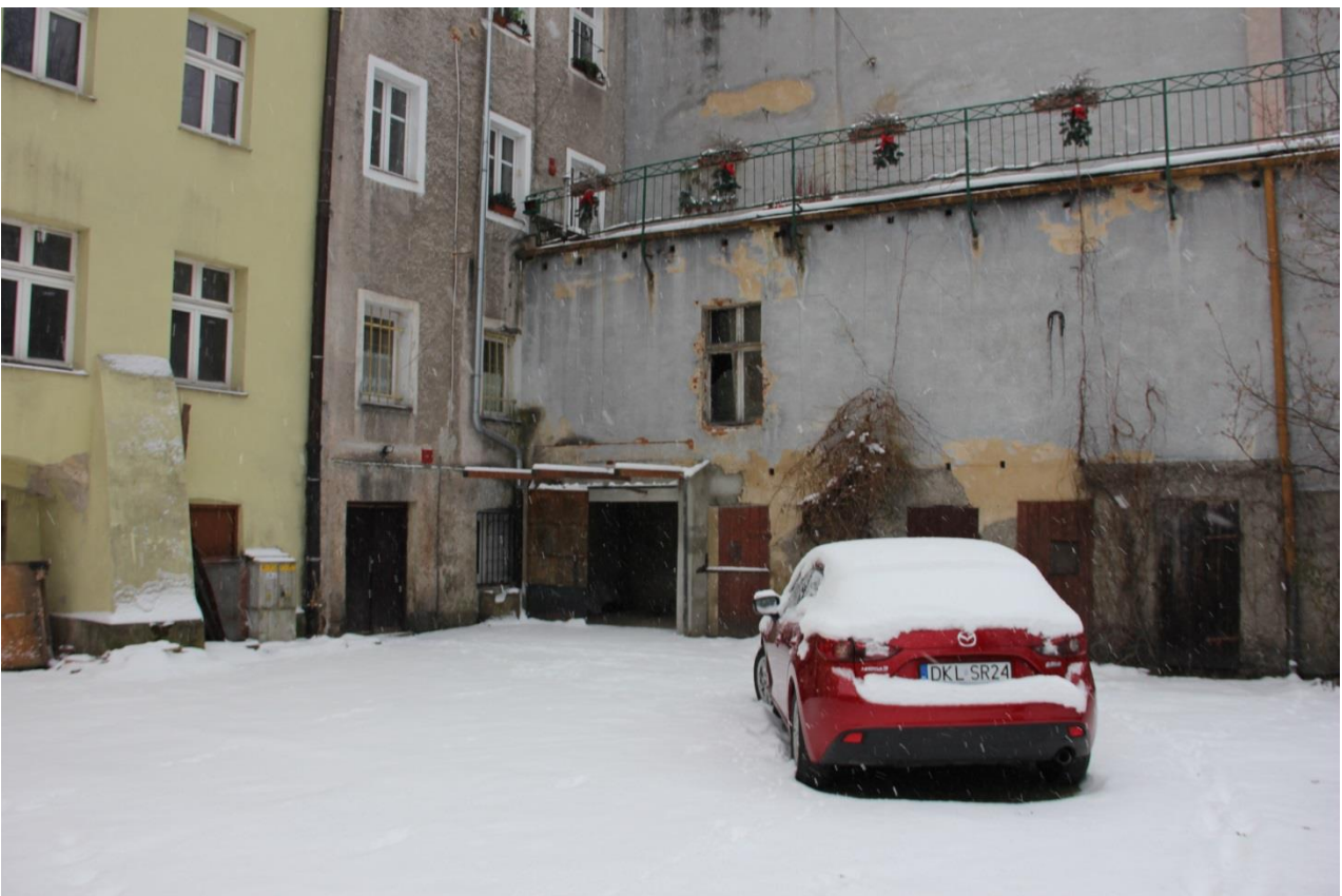
zdjęcie 7 Wejścia do budynków – zachodnia część terenu
