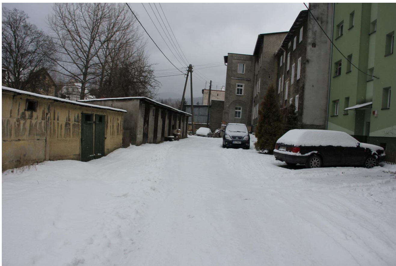
Zdjęcie budynków gospodarczych przeznaczonych do rozbiórki.
