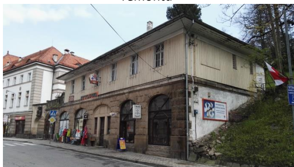
Fotografia: budynek mieszkalno-usługowy przy ul. Kościuszki, zgłoszony do adaptacji pod inne funkcje
