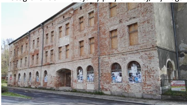
Fotografia: budynek hotelowy w przebudowie przy ul. Skłodowskiej-Curie
